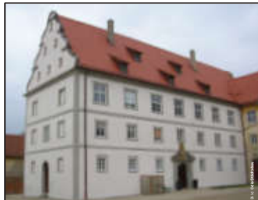
Sanierter Prinzessinnenbau des Residenzschlosses
