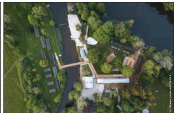
Luftbild Realisierungsteil nach Fertigstellung
