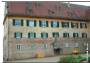
Außensicht vor der Sanierung
